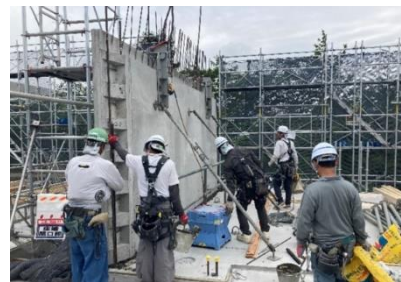
〔PC 板の揚重・取り付けの様子〕
