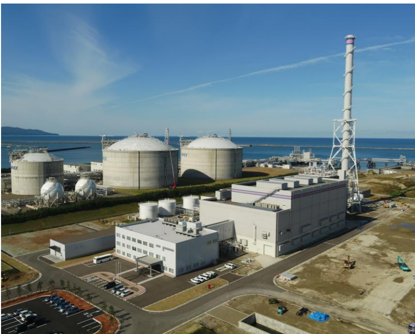
▲ 新潟県上越市 上越火力発電所(写真提供：東北電力)
